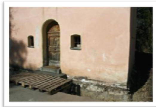
Im heurigen Jahr wird nun die Kapelle Außen restauriert. Es erfolgt eine Entfeuchtung des Mauerwerkes, das Dach wird erneuert und der Außenanstrich muss nach Ausbesserungen des Mauerwerkes erneuert werden.
